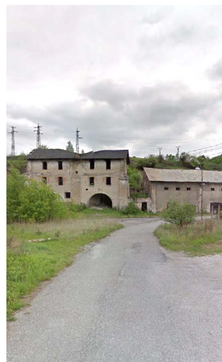
Chátrajúca budova bývalej vodnej elektrárne pri Krompachoch. Pred 125 rokmi to bola prvá vodná elektrárňu v severnom Uhorsku.
